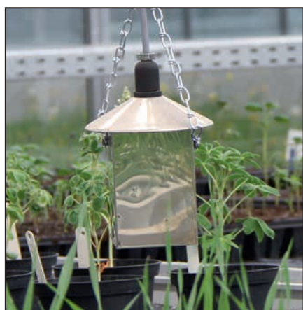
Foto 5: Sensore di temperatura con protezione dalle radiazioni. Mentre i sensori di regolazione devono essere installati direttamente nel supporto, il posizionamento migliore per i sensori di allarme è nei punti in cui le deviazioni del valore monitorato sono più velocemente percepite.
