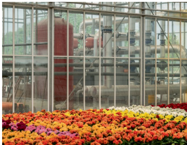
Foto 4: Azienda orto-vivaistica con sistema di riscaldamento separato.
