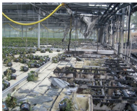
Foto 5: Danni da incendio limitati grazie all'installazione di schermo B1.
