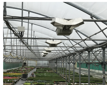
Foto 6: Sistema moderno di assimilazione con distanza sufficiente da materiali infiammabili.
