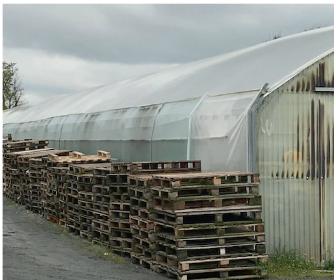
Foto 3: Il materiale infiammabile non deve essere depositato lungo le pareti laterali esterne delle serre.
